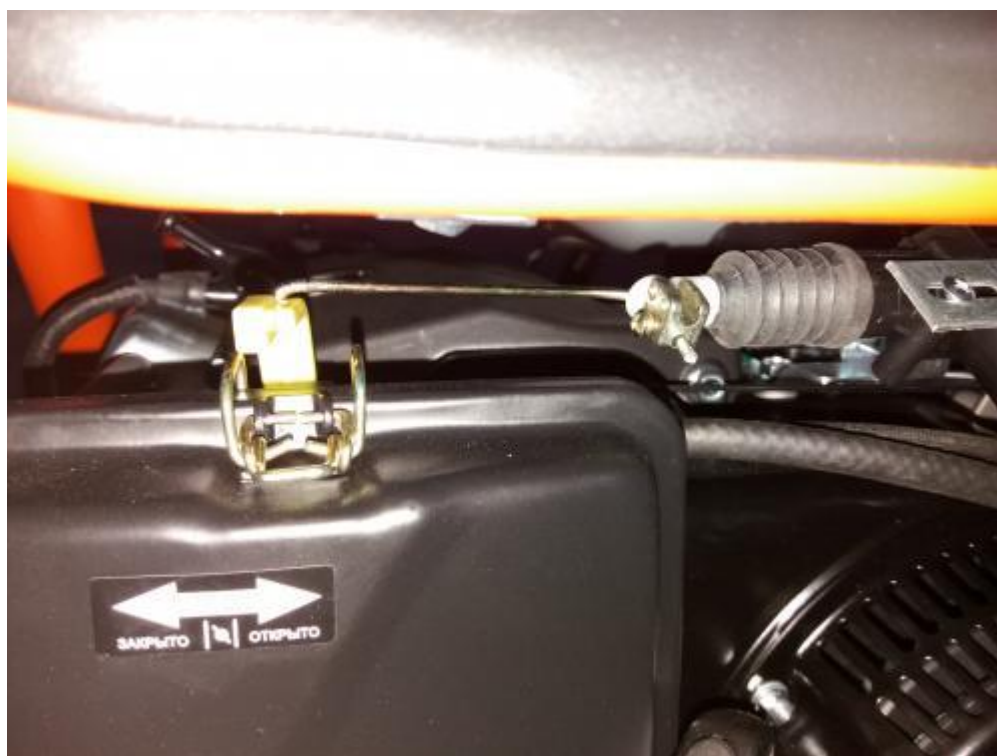
Рис.5 Установка электропривода воздушной заслонки.
